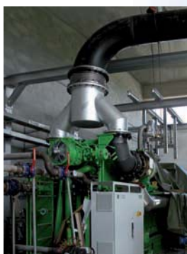
Condotto fumi DN 600 per cogeneratore da 5 MWatt, in acciaio inossidabile ferritico (Centrale teleriscaldamento Borgaro Torinese).
