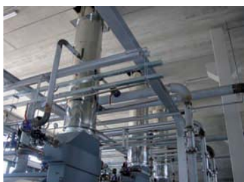
Camini DN 800 in doppiaparete per utenze da 6 MWatt a condensazione (Centrale teleriscaldamento di Borgaro Torinese)
