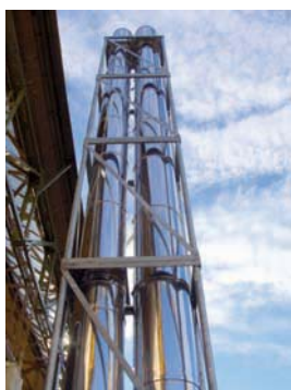
Camini con struttura portante a traliccio in acciaio ad alta resistenza zincato a caldo H 10 m ( Centrale termica Rmt Valvomeccanica, Solbiate O.)
