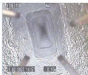
● Cod. SCS ISP Videoispezione camino Chimney visual inspection
