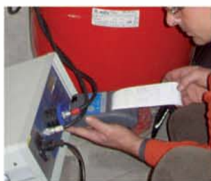
● Cod. SCS CPT Prova di tenuta dei camini Chimney tightness test
