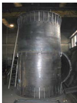
Elemento di camino autoportante durante la fase di preassemblaggio e saldatura in officina.
