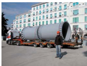
Elementi di camino autoportante DN 2400 - H 28 m in acciaio ad alta resistenza durante la fase di trasporto (Nuovo polo logistico Ospedale Niguarda Ca' Granda di Milano)
